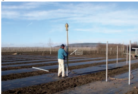
V těchto dnech probíhají intenzivní práce na výstavbě pěstitelsko-prodejních záhonů
